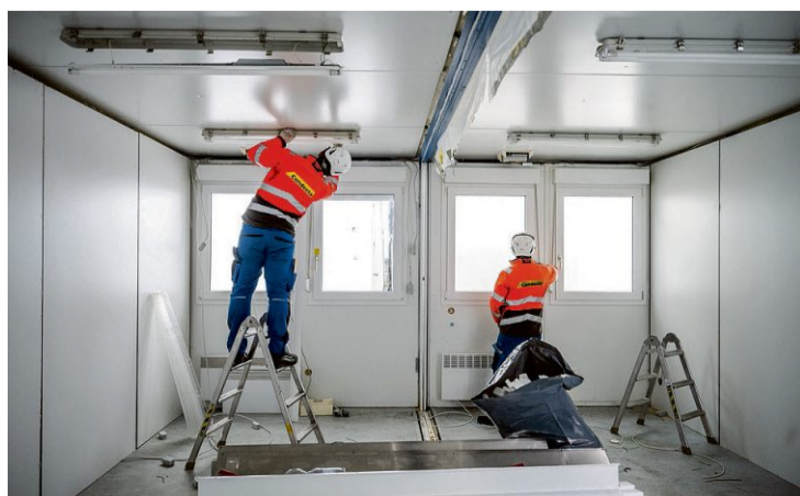
Monteure rüsten einen der Container-Rohlinge für Wohnzwecke um.
