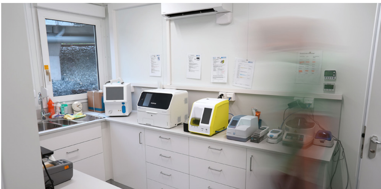
Labor mit Rückwand und Kabelkanal, Durchreiche WC-Labor
