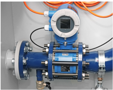
Beispiel integrierte Wassermessung
