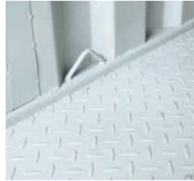
Sol en acier en tôle striée de 3 mm, entièrement soudé avec crochet
