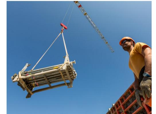
Les grues à montage rapide EURO 4513 et 4515 - avec leur portée de 45 mètres pour une charge principale de 6'000 kilogrammes, les grands sœurs du type EURO 4312 - se caractérisent par leur travail précis et sans à-coups grâce à des entraînements à convertisseur de fréquence à commande électronique et à réglage continu, avec un courant de démarrage maximal de 40 ampères. Par ailleurs, leur hauteur sous crochet
