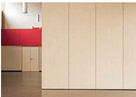
Aucun guidage au sol, suspension libre, cloison pouvant coulisser individuellement sur un rail en aluminium monté au
