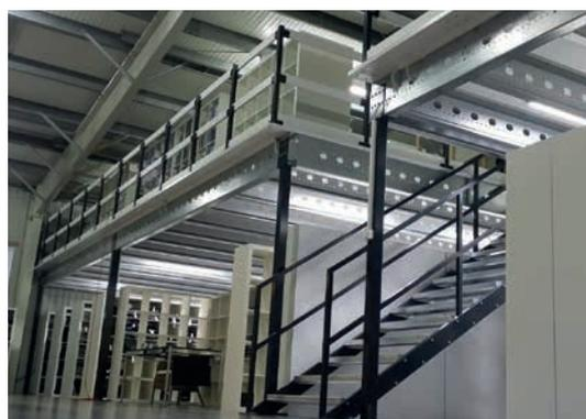
Mezzanine de stockage avec système de rayonnage intégré
