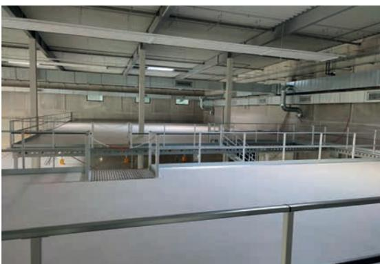
Mezzanine de stockage avec chargement de palette et chaîne de sécurité
