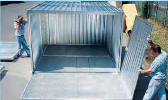
Wannen ausrichten und Verbindungselemente einlegen ...
