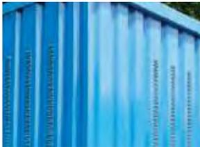
Lüftungskiemens sorgen bei der passiven Lagerung für die nötige Eigenbelüftung.
