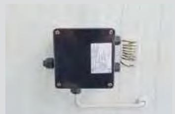
Der Temperaturregler mit Fühler sorgt dafür, dass die eingestellte Temperatur eingehalten wird.
