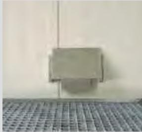
Durch die mechanische Belüftung bei der aktiven Lagerung erfolgt eine Luft-Durchflutung unterhalb des Gitterrostes und innerhalb des Containers.
