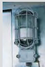
Die Elektroinstallationspakete sind je nach Ausführung auf die jeweiligen Erfordernisse abgestimmt. Die Ausführungen für aktive und passive Lagerung enthalten u. a. eine explosionsgeschützte Wandlampe innen.
